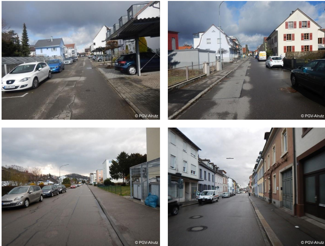
Abb. 3-32: Bestand: Bündtenstraße, Hellbergstraße, Hartmattenstraße, Kreuzstraße (v.l.n.r.)
