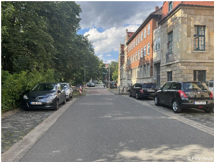
Abb. 1-4: Fahrbahneinengung mit Aufpflasterung zur Geschwindigkeitsreduzierung
