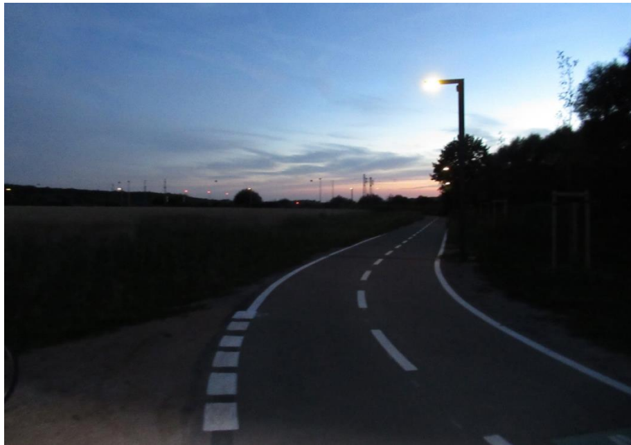
Abb. 4-24: RSV mit adaptiver Beleuchtung
