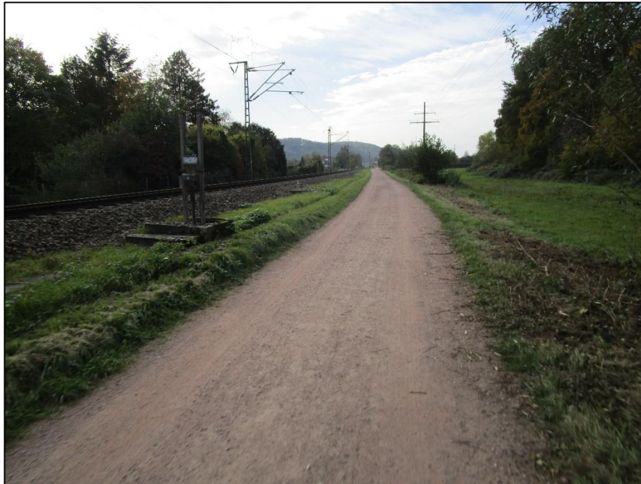
Abb. 3-49: Variantenverlauf auf Schotterweg entlang der Bahngleise (Südseite)
