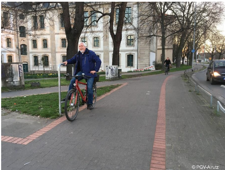
Abb. 4-30: Bügel als „Wartehilfe“ vor einer Lichtsignalanlage (Hannover)
