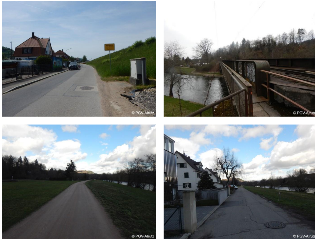
Abb. 3-29: Bestand: Landstraße/Straßendamm B 317, Blick über Wiese entlang Eisenbahnbrücke, Wiesevorland, Jahnstraße (v.l.n.r.)
