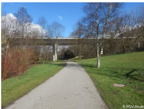
Abb. 3-33: Bestand: Wilhelm-Wagner-Straße, WV unter Bundesstraßenanschluss hindurch, WV unter Autobahn hindurch, Kreuzstraße (v.l.n.r.)
