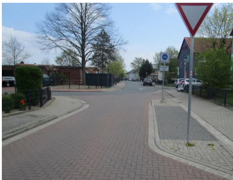
Abb. 1-3: Untergeordnete Knotenpunktzufahrt einer Fahrradstraße mit abknickender Vorfahrt (Burgdorf)
