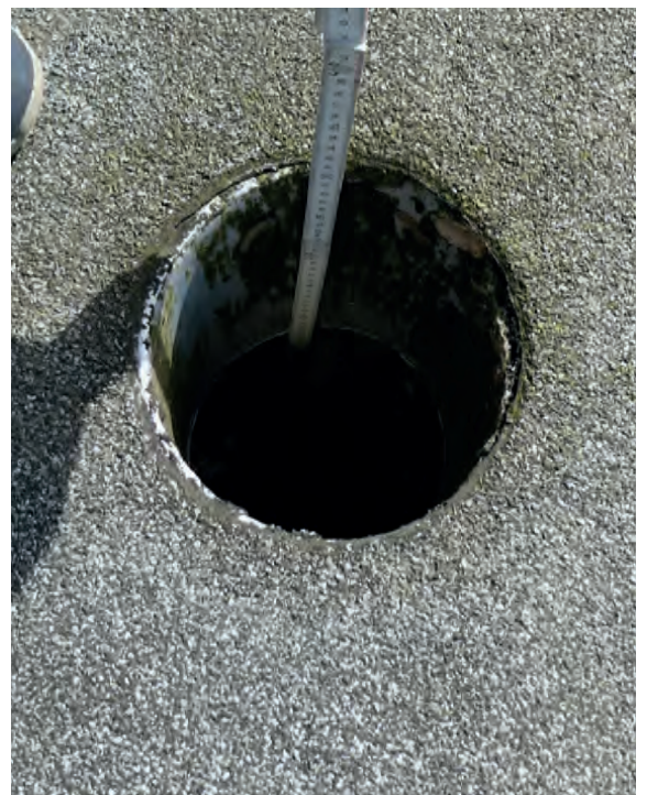
Foto 64: Sporthalle – Flachdach Übersicht und Detailaufnahme Westlicher Flachdachabschnitt Foto links: Flachdachablauf ohne Laubfang und Notüberlauf mit Abdeckung Foto rechts: Flachdachablauf
