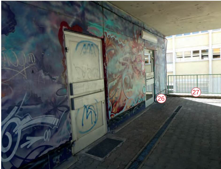
Foto 18: Außenanlage/Schulhof, südwestlicher Abschnitt Übersicht im Hintergrund: Treppenhaustür im Vordergrund: Tür zu Lüftungstechnikraum
