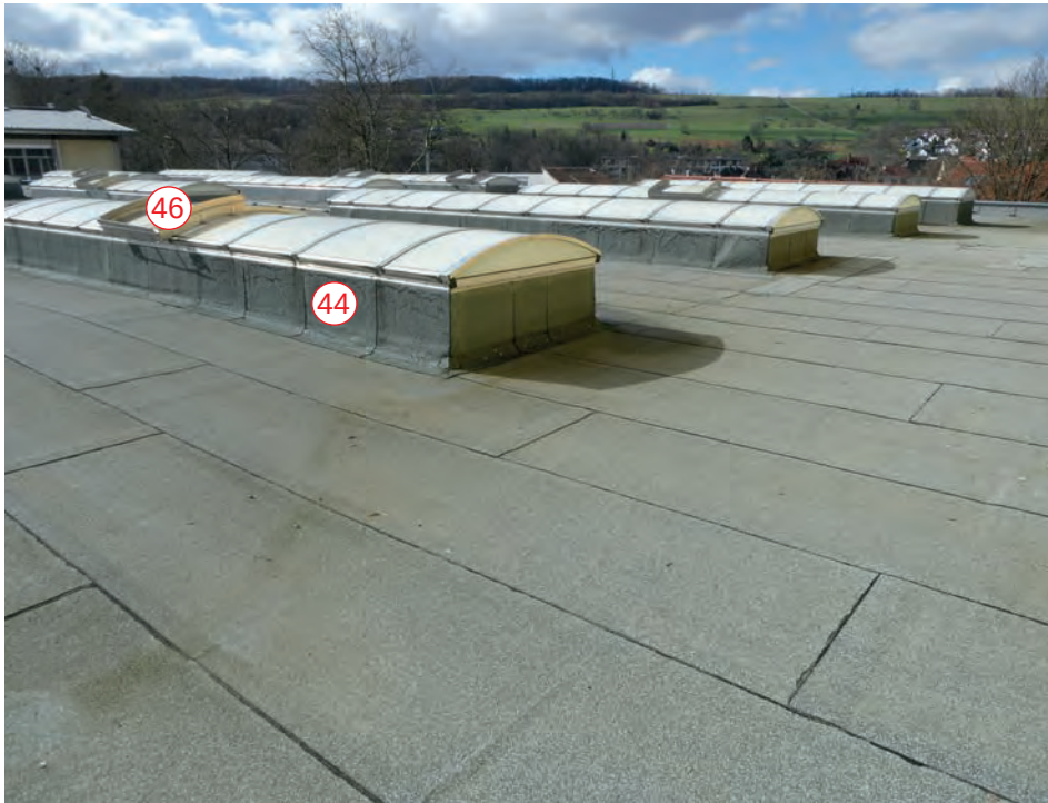
Foto 43: Sporthalle – Flachdach Übersicht Lichtbänder
