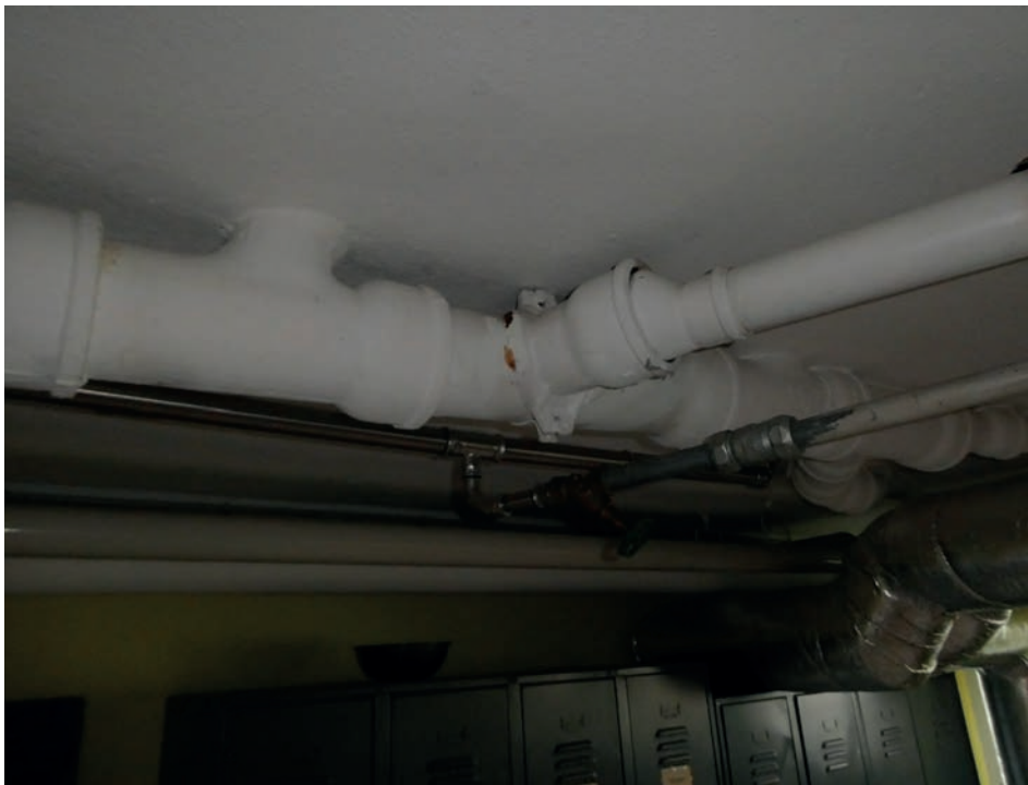
Foto 138: Innenbereich – Schule Übersicht
