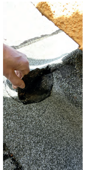
Foto 70: Sporthalle – Flachdach Übersicht und Detailaufnahme Südwestliche Giebelwand Kaufmännische Schule Lörrach Foto links: Versatz in Giebelwand und Sockelausbildung Foto rechts: "Abdichtungsflick" unterhalb Außenecke/Versatz Giebelwand nicht auf Untergrund haftend
