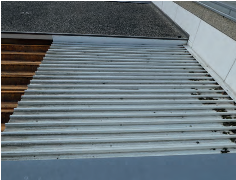
Foto 40: Sporthalle – Flachdach Übersicht Überdachter Außenbereich zwischen Flachdach über Treppenhaus und Flachdach Haustechnikraum
