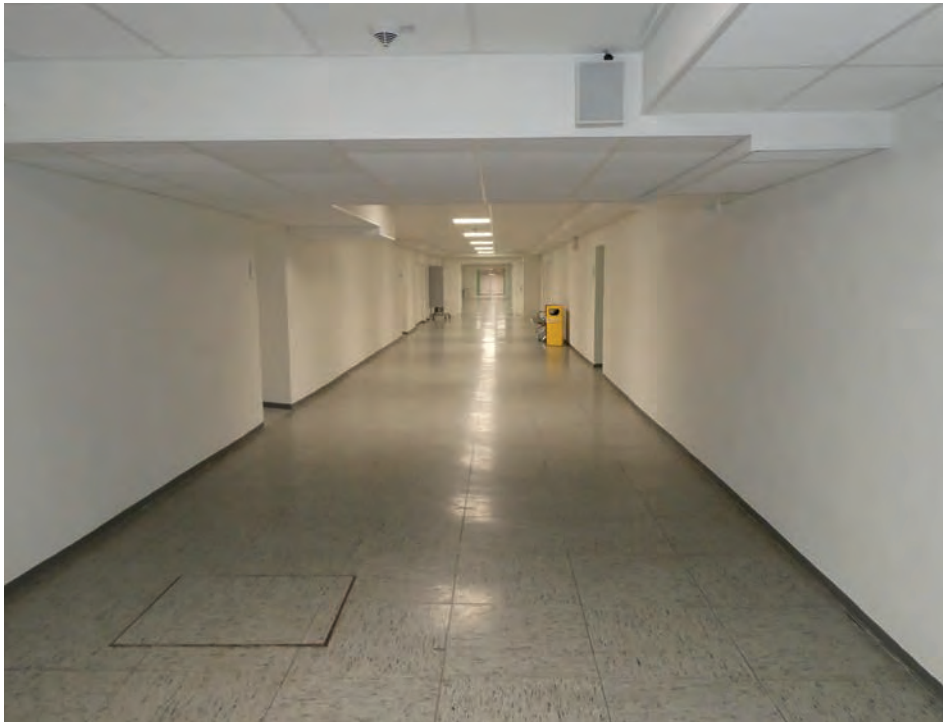
Foto 133: Schulgebäude – Untergeschoss Übersicht Flur
