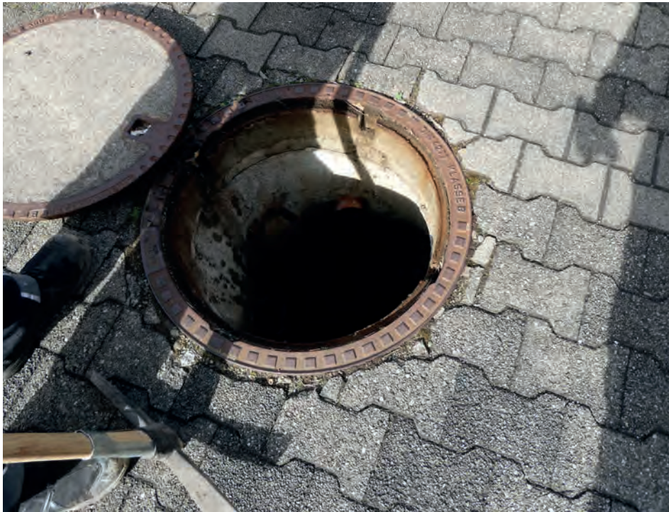
Foto 36: Außenbereich – Schulhof Übersicht Kontrollschacht
