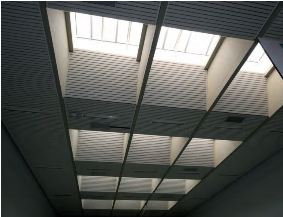
Foto 97: Sporthalle – mittleres Hallendrittel Übersicht Untersicht Decke und Lichtbänder
