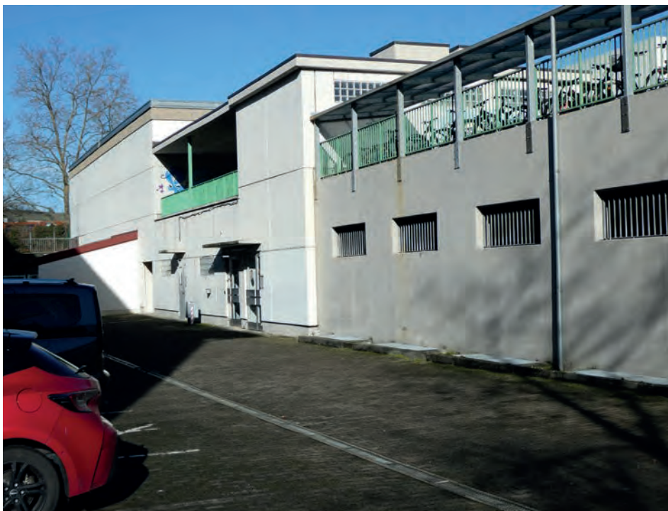
Foto 02: Sporthalle – Südwestfassade Übersicht im Hintergrund: Sporthallenansicht – Südwestfassade im Vordergrund: Tiefgaragenansicht – Südwestfassade
