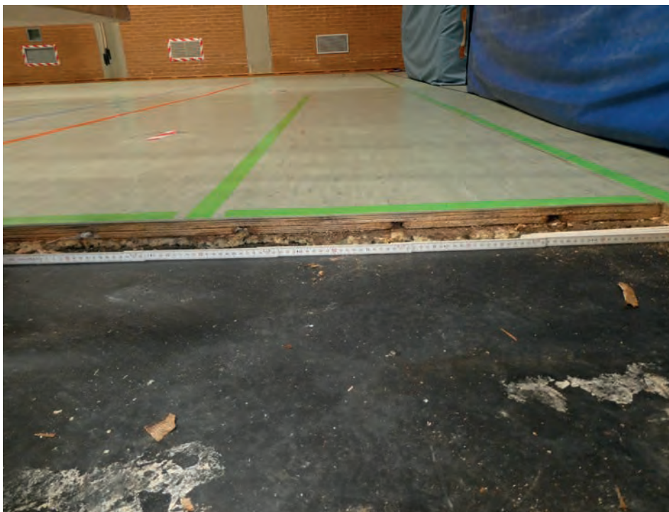
Foto 123: Sporthalle – nördliches Hallendrittel Übersicht und Detailaufnahme Bodenaufbau Foto rechts: Maße Bodenschichten (von unten nach oben) – Dämmung: ca. 18 mm, Sperrholzplattenschicht, zweilagig, Gesamtdicke: ca. 24 mm; Oberbelag: ca. 3,5 mm
