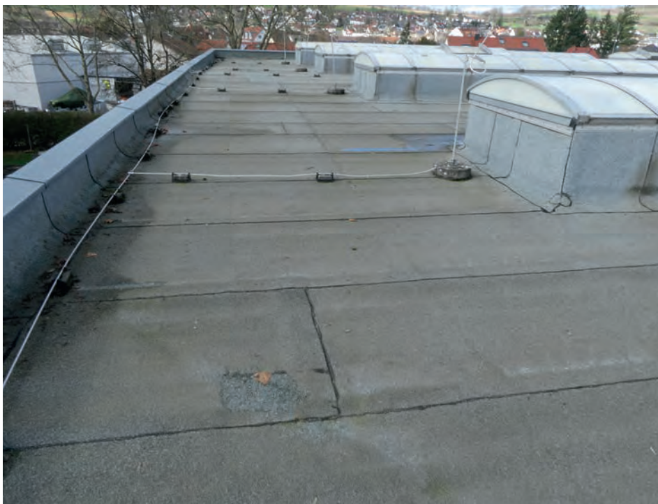
Foto 58: Sporthalle – Flachdach Übersicht südwestlicher Flachdachabschnitt Blitzschutzfangstange auf Betonsockel
