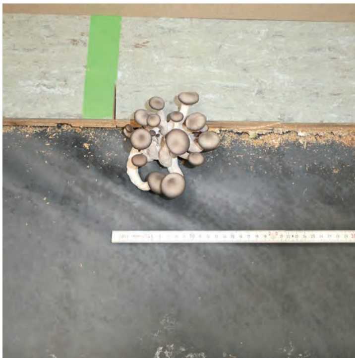
Foto 131: Sporthalle – nördliches Hallendrittel Detailaufnahmen – Pilzfruchtkörper Hallenboden hinter Absperrung Foto links: Blick von oben auf Pilzfruchtkörper Foto rechts: Seitenansicht Pilzfruchtkörper
