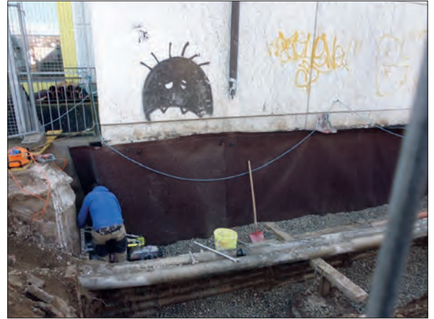
Abb. 13 Nordwestfassade, nördliches Ende Schutzlage vor Abdichtung, Rollkiesauffüllung
