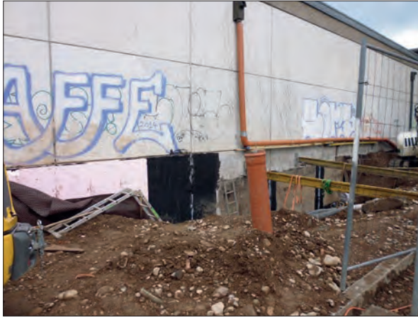
Abb. 12 Nordwestfassade – Abdichtung partiell Fugenbänder, Dämmung und Schutzlage
