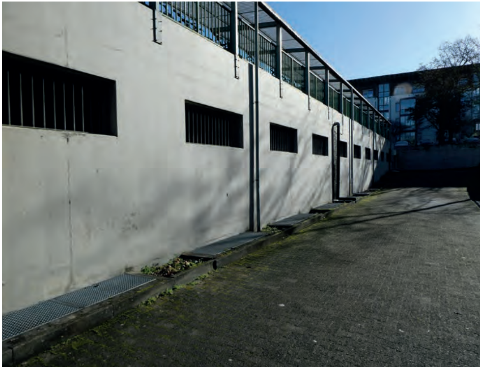
Foto 05: Sporthalle – Südwestfassade Übersicht Tiefgaragenansicht – Südwestfassade
