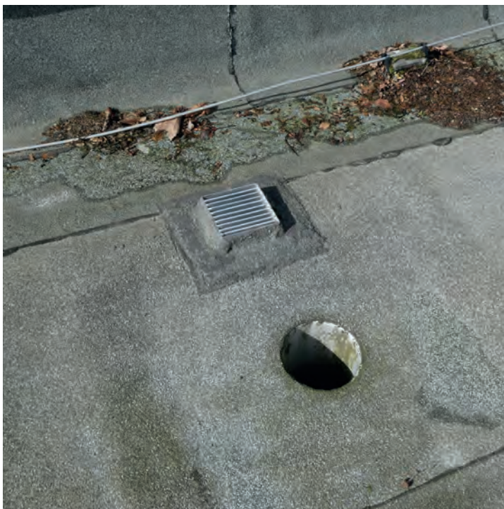
Foto 64: Sporthalle – Flachdach Übersicht und Detailaufnahme Westlicher Flachdachabschnitt Foto links: Flachdachablauf ohne Laubfang und Notüberlauf mit Abdeckung Foto rechts: Flachdachablauf
