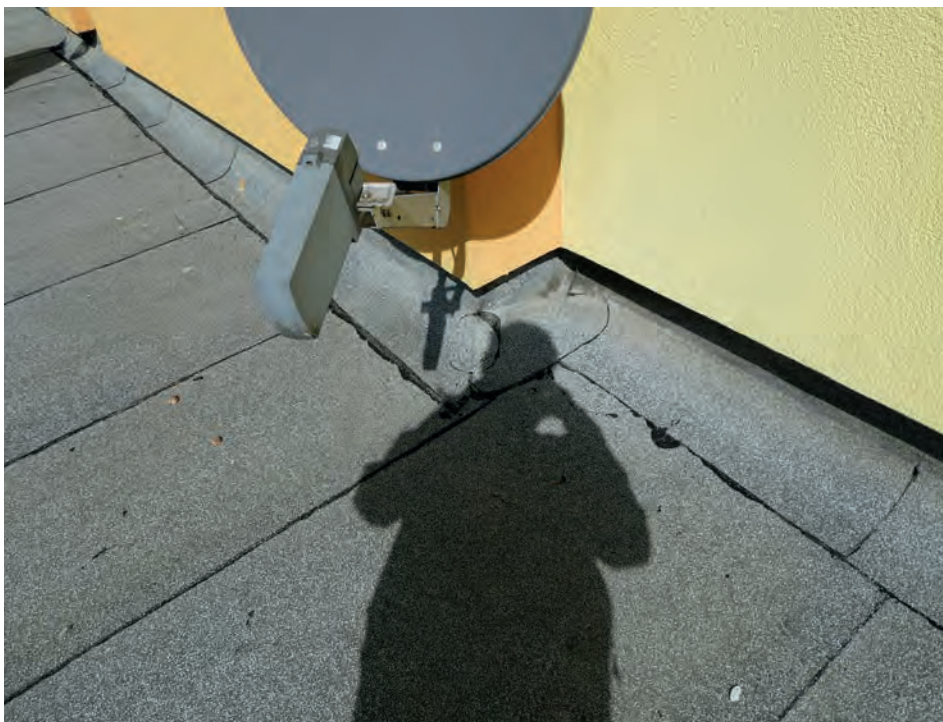
Foto 70: Sporthalle – Flachdach Übersicht und Detailaufnahme Südwestliche Giebelwand Kaufmännische Schule Lörrach Foto links: Versatz in Giebelwand und Sockelausbildung Foto rechts: "Abdichtungsflick" unterhalb Außenecke/Versatz Giebelwand nicht auf Untergrund haftend
