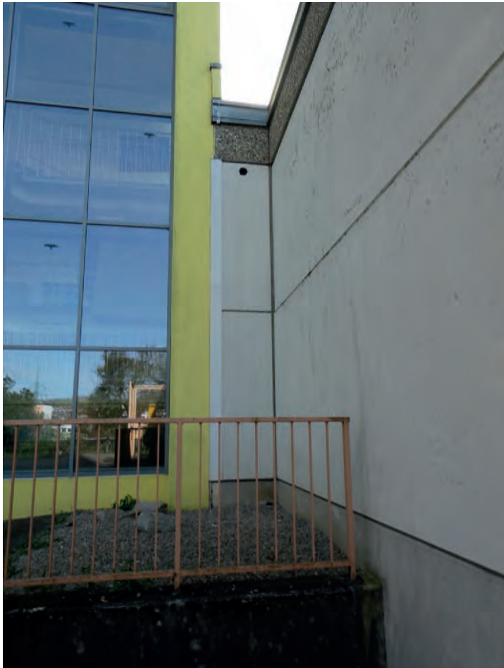
Foto 13: Außenbereich – Nordostfassade Übersicht Übergangsbereich zwischen nordöstlichem Sporthallenfassadenabschnitt und südwestlichem Schulgebäudegiebel
