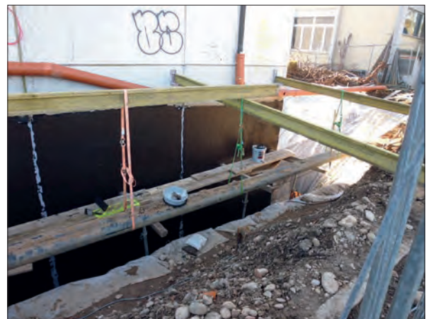
Abb. 9 Nordwestfassade – Abdichtung und Fugenbänder
