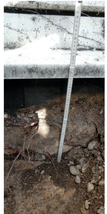
Foto 32: Sondageöffnung 02 – Innenecke zwischen Nordostwand/Technikraum und Südostwand Sporthalle Übersicht
