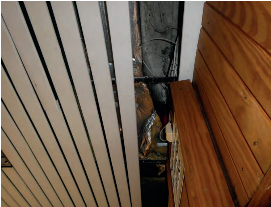
Foto 88: Innenbereich – Mittelflur Übersicht Flurabschnitt zu südlichem und mittlerem Hallendrittel Deckenuntersicht
