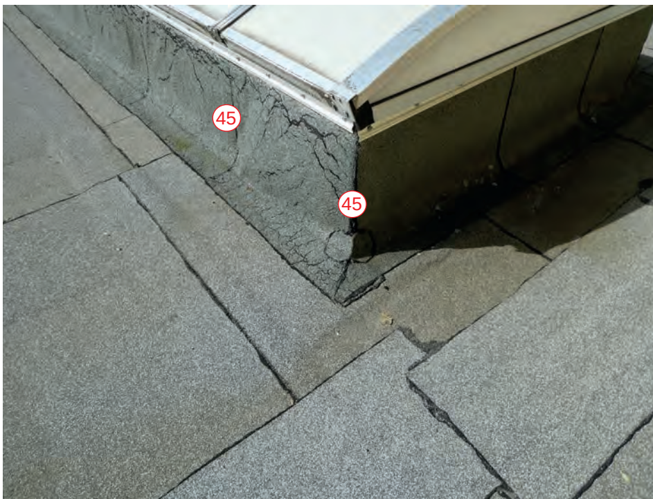
Foto 44: Sporthalle – Flachdach Übersicht Außenecke Lichtbandaufkantung
