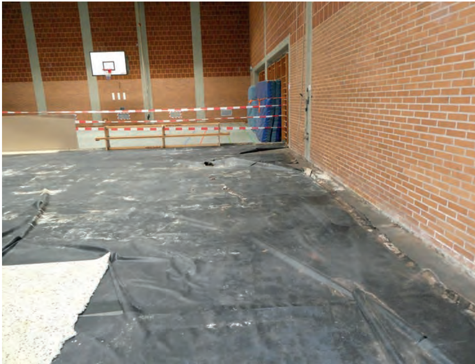
Foto 104: Sporthalle – nördliches Hallendrittel Übersicht aufgenommene Hallenbodenteilfläche hinter Absperrung
