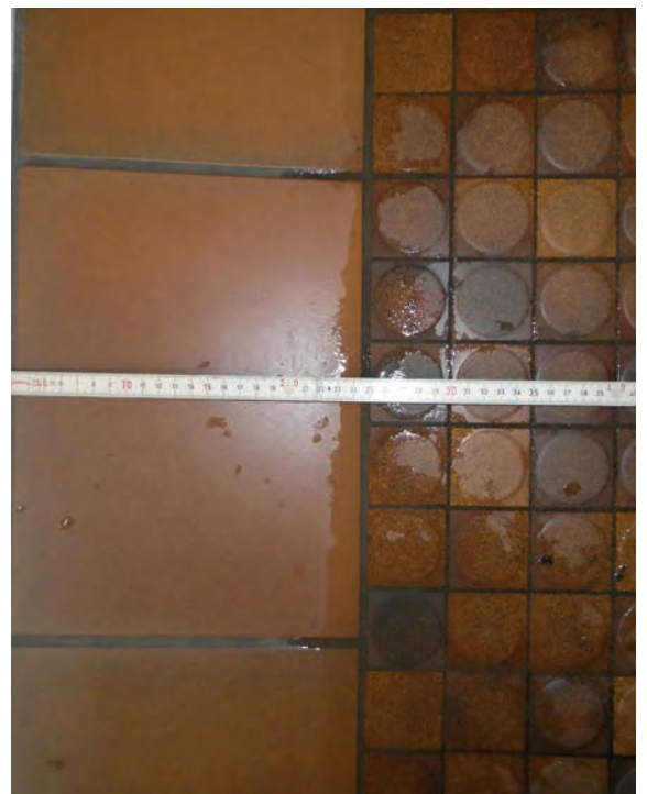
Foto 87: Innenbereich – Mittelflur Übersicht und Detailaufnahme Flurabschnitt mit Zugängen zu südlichem und mittlerem Hallendrittel Foto links: Türöffnung links zu südlichem Hallendrittel und Türöffnung rechts zu mittlerem Hallendrittel Foto rechts: Wasserpfütze unterhalb südlicher Gebäudedehnfuge
