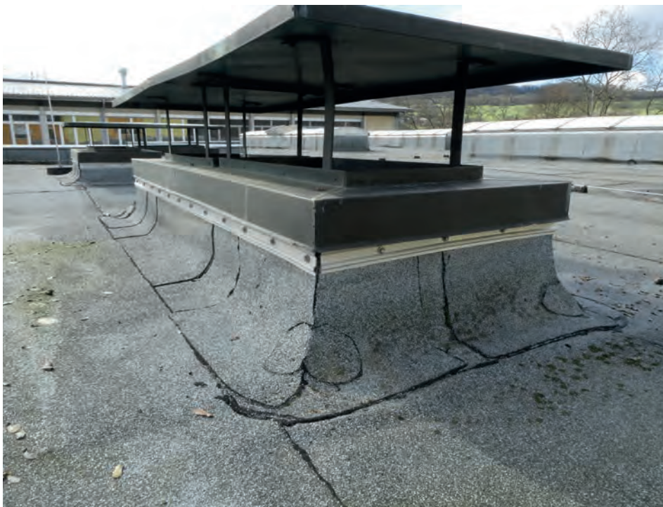
Foto 54: Sporthalle – Flachdach Übersicht Dachdurchdringungen mit Abdeckung in Decke oberhalb Haustechnikraum
