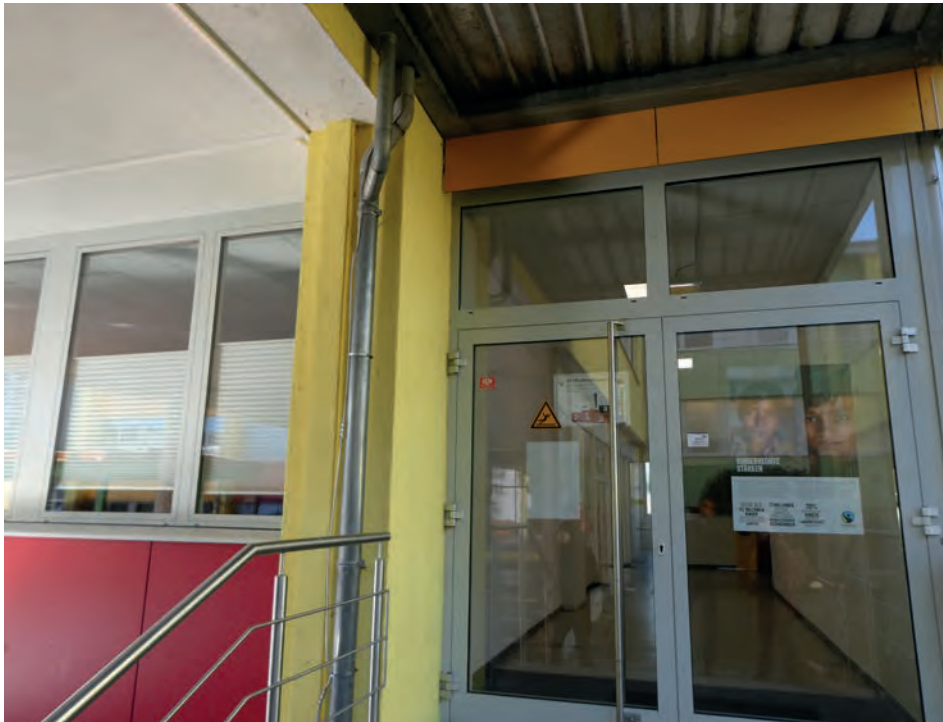
Foto 24: Außenanlage/Schulhof Übersicht südöstlicher Eingang Schulgebäude
