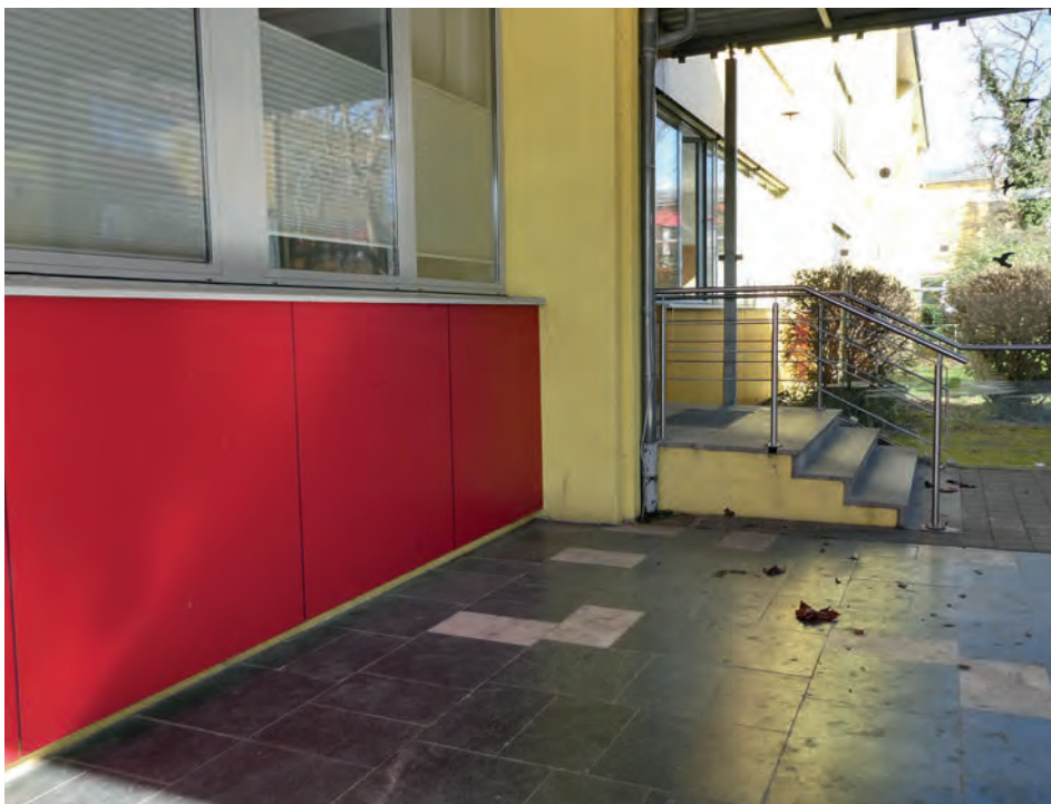
Foto 23: Außenanlage/Schulhof Übersicht südöstlicher Eingang Schulgebäude
