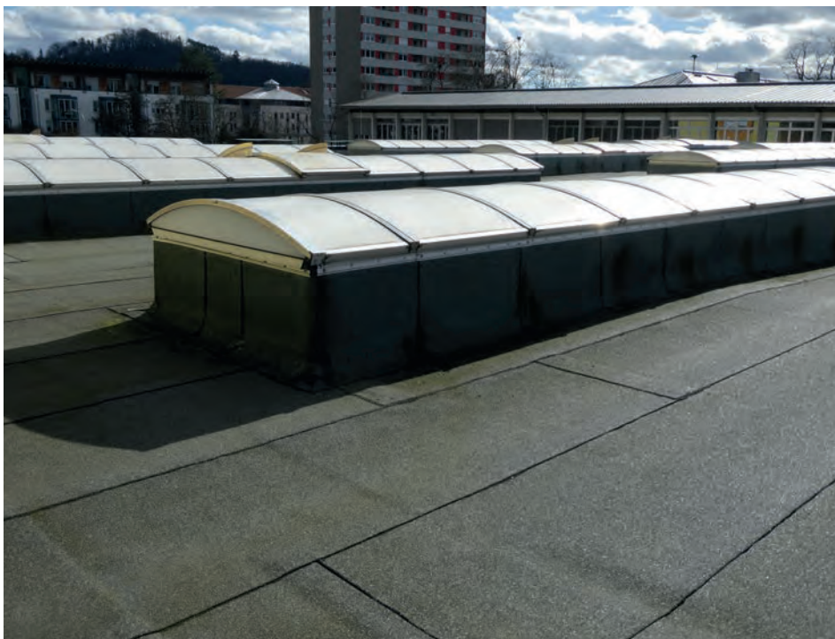
Foto 68: Sporthalle – Flachdach Übersicht Lichtbänder
