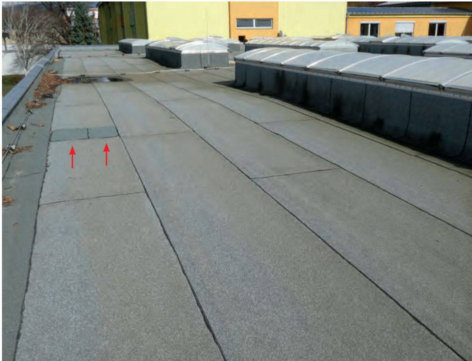
Foto 63: Sporthalle – Flachdach Übersicht Westlicher Flachdachabschnitt Verlegung zusätzlicher Abdichtungsbahnenabschnitte
