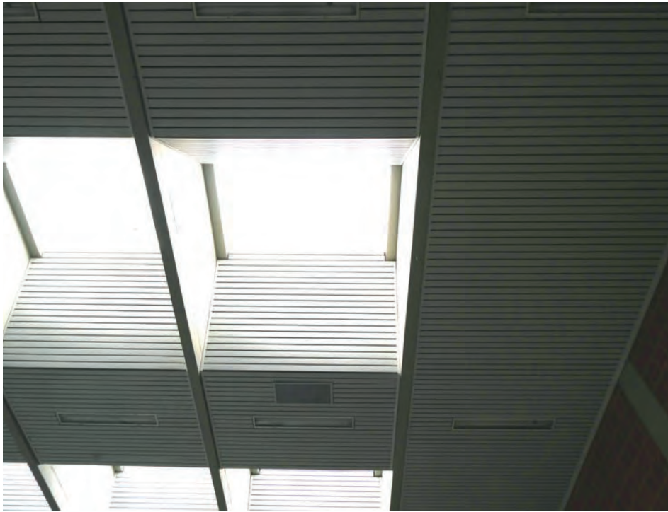
Foto 99: Sporthalle – mittleres Hallendrittel Übersicht Untersicht Decke und Lichtbänder
