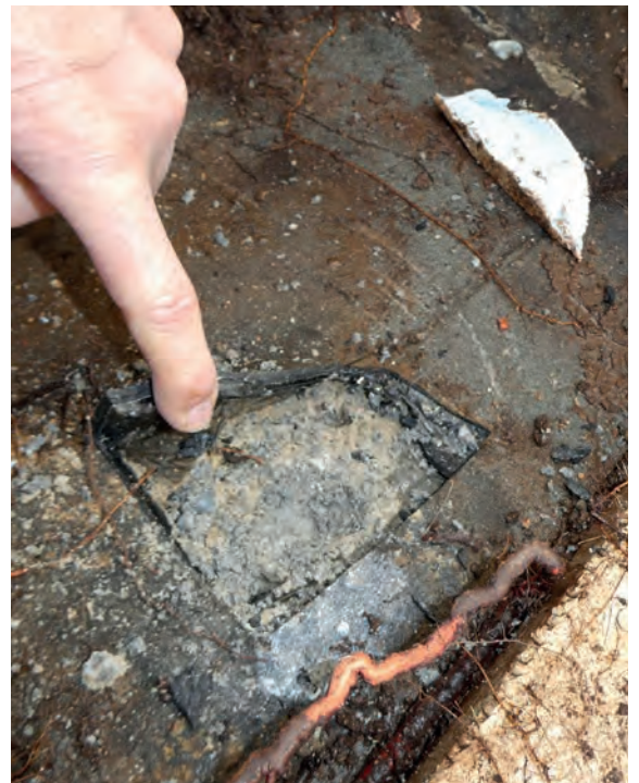
Foto 35: Sondageöffnung 02 Detailaufnahmen Foto links: kraftschlüssiger Verbund zwischen Stahlbetonoberfläche und Abdichtungsbahn nicht vorhanden Foto rechts: Stahlbetonoberfläche feucht
