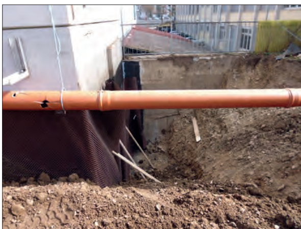
Abb. 10 Außenecke Nord-/Südwestfassaden Schutzbahn vor Abdichtung
