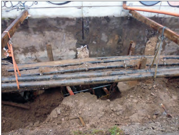
Abb. 6 Nordwestfassade – Fuge, Abdichtung und Schutz
