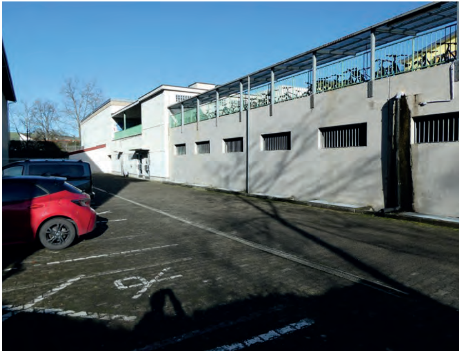
Foto 01: Sporthalle – Südwestfassade Übersicht im Hintergrund: Sporthallenansicht – Südwestfassade im Vordergrund: Tiefgaragenansicht – Südwestfassade
