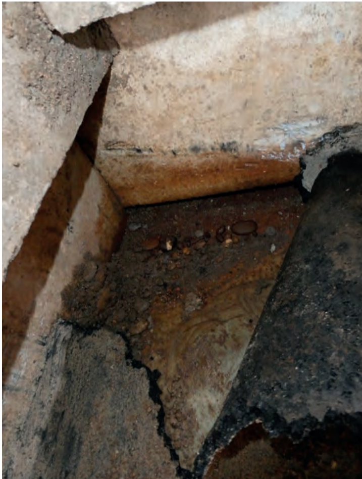
Foto 28: Sondageöffnung 01 – Süd Detailaufnahme Bodenaufbau, d. h. Pflasterbelag und Bettungsmaterial oberhalb Bauten- schutzmatte aufgenommen
