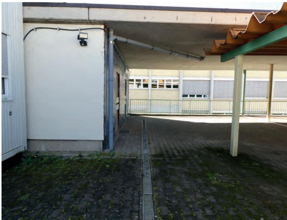
Foto 19: Außenanlage/Schulhof, südwestlicher Abschnitt Übersicht
