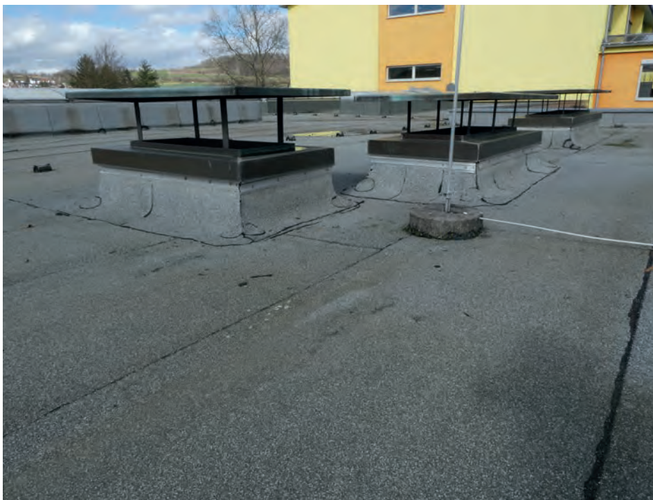
Foto 56: Sporthalle – Flachdach Übersicht Dachdurchdringungen mit Abdeckung in Decke oberhalb Haustechnikraum Blitzschutzfangstange auf Betonsockel
