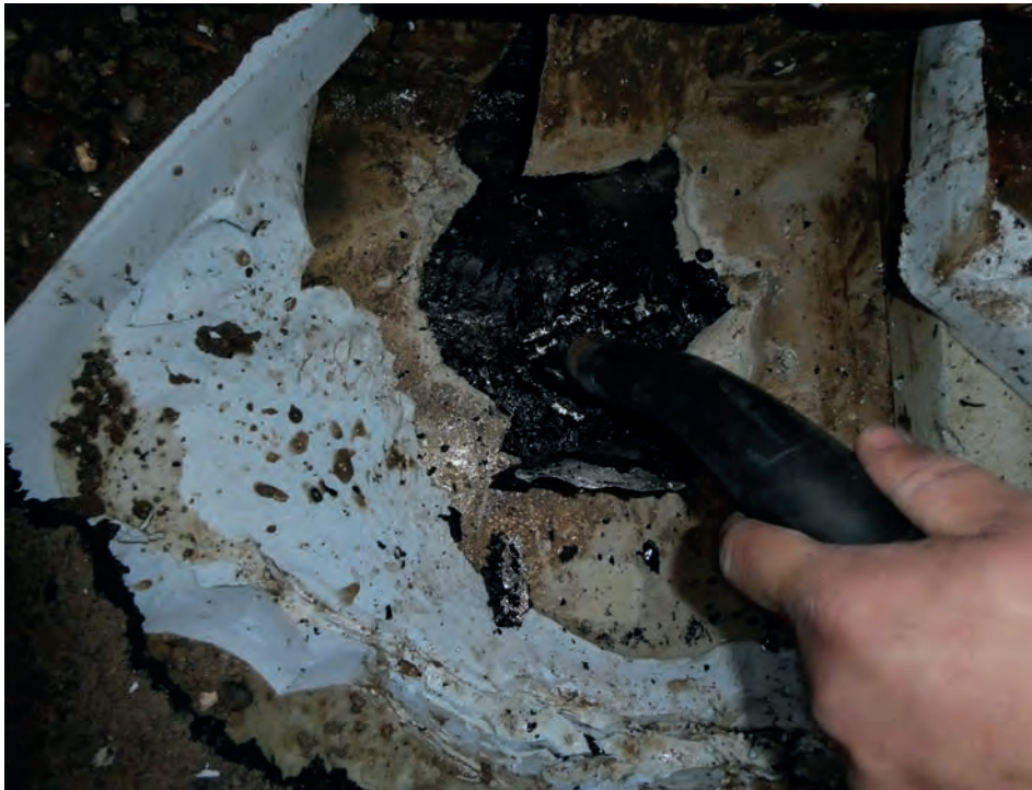
Foto 30: Sondageöffnung 01 – Süd Detailaufnahme Dämmschicht zweilagig Dämmmaterial punktuell entfernt Wasserabsaugen von Abdichtungsoberfläche
