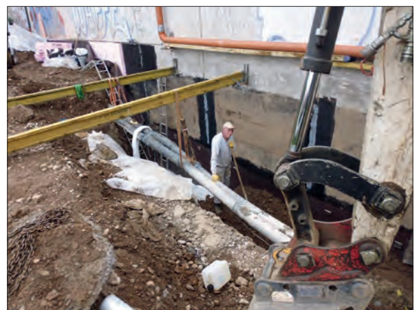
Abb. 11 Nordwestfassade – Abdichtung partiell, Fugenbänder, Dämmung und Schutzlage
