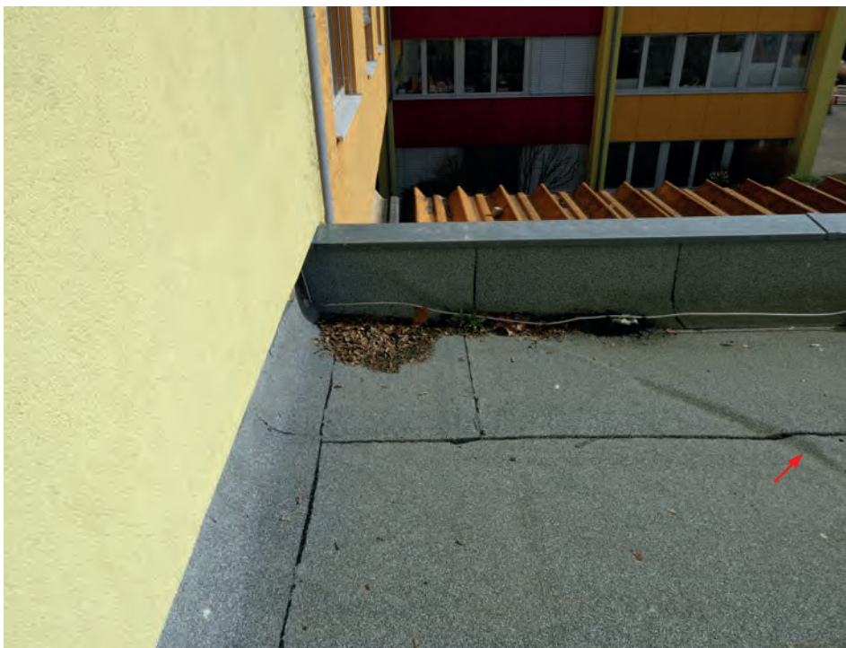
Foto 50: Sporthalle – Flachdach Übersicht Südwestliche Giebelwand Kaufmännische Schule Lörrach; nordöstliche Flachdachecke
