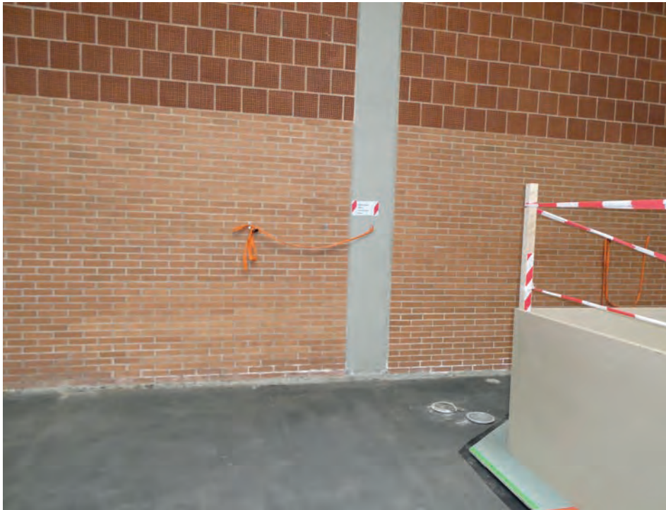
Foto 110: Sporthalle – nördliches Hallendrittel Übersicht aufgenommene Hallenbodenteilfläche hinter Absperrung
