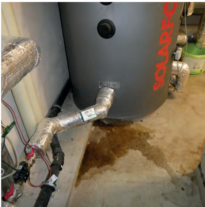
Foto 72: Haustechnikraum Übersicht Wasser auf Boden neben/unterhalb Pufferspeicher
