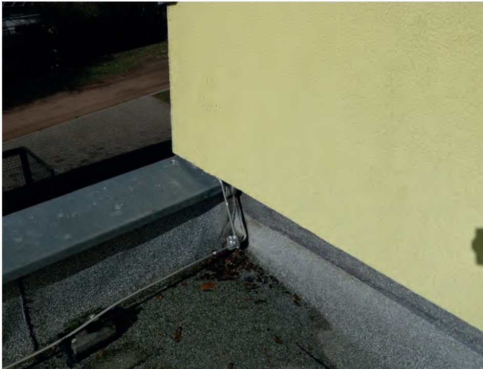
Foto 69: Sporthalle – Flachdach Übersicht Südwestliche Giebelwand Kaufmännische Schule Lörrach; nordwestliche Flachdachecke
