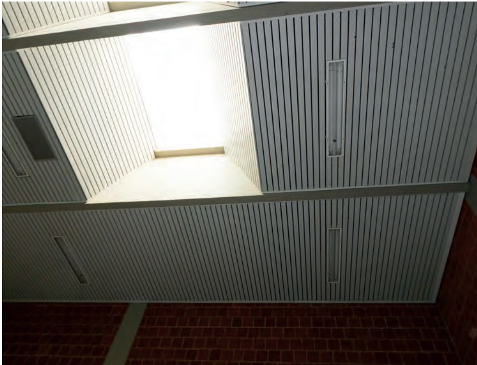
Foto 94: Sporthalle – mittleres Hallendrittel Übersicht Untersicht Decke und Lichtband
