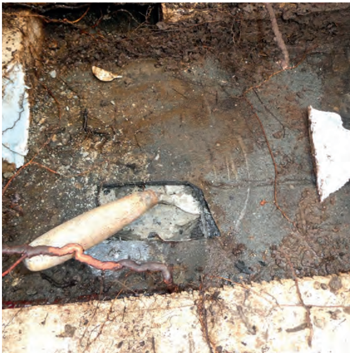
Foto 35: Sondageöffnung 02 Detailaufnahmen Foto links: kraftschlüssiger Verbund zwischen Stahlbetonoberfläche und Abdichtungsbahn nicht vorhanden Foto rechts: Stahlbetonoberfläche feucht
