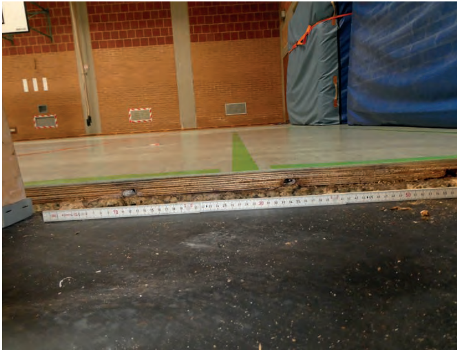
Foto 122: Sporthalle – nördliches Hallendrittel Detailaufnahme Bodenaufbau
