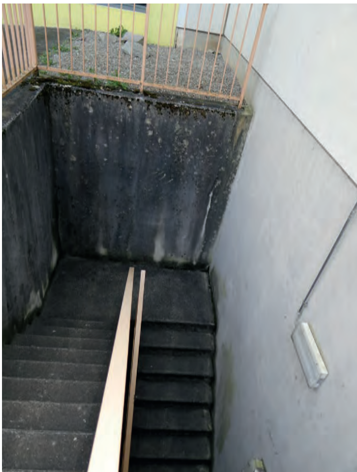
Foto 14: Außenbereich – Nordostfassade Detailaufnahmen Außentreppe zu Sporthallenneben- eingang
