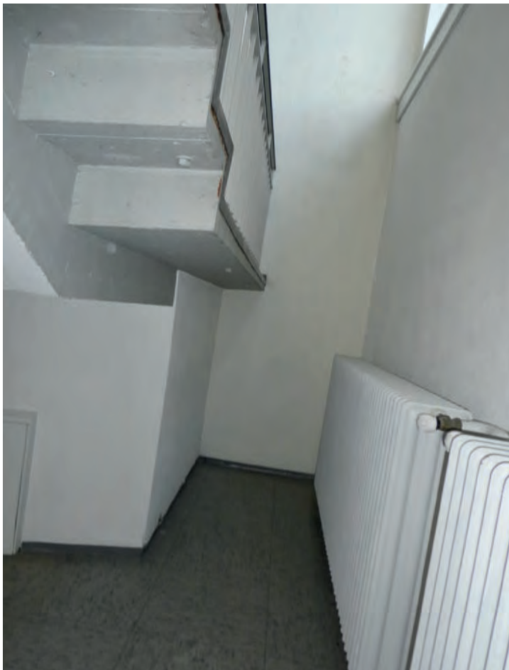
Foto 134: Schulgebäude – Untergeschoss Übersicht Treppenhaus Blick auf Innenseite südwestliche Giebelwand
