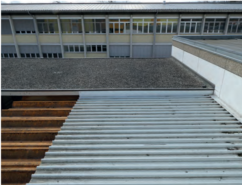
Foto 39: Sporthalle – Flachdach Übersicht Überdachter Außenbereich zwischen Flachdach über Treppenhaus und Flachdach Haustechnikraum
