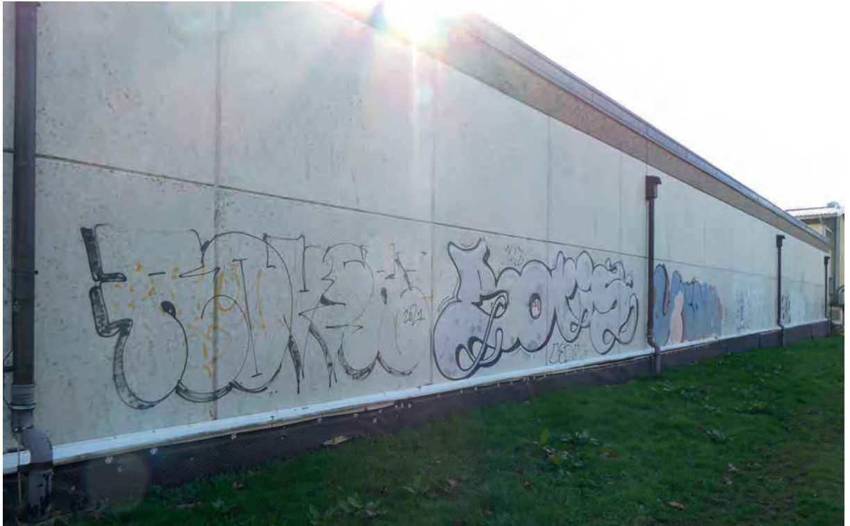
Abb. 2 Fassade Nord-West (Foto von Unterzeichnern – 23.02.2024)
