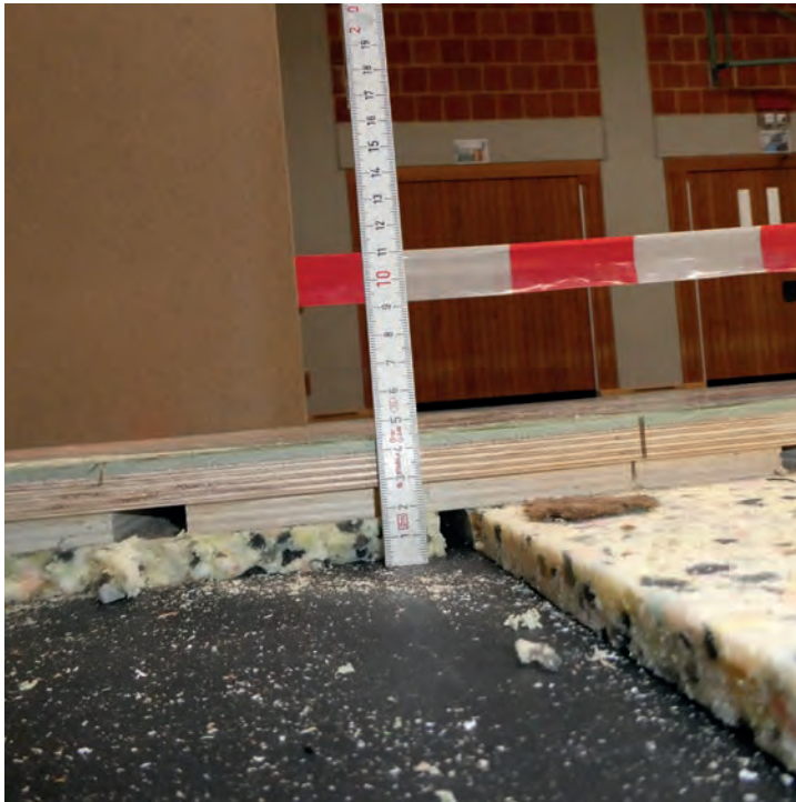
Foto 124: Sporthalle – nördliches Hallendrittel Detailaufnahmen Bodenaufbau – Messung Schichtdicken mit Holzgliedermaßstab
