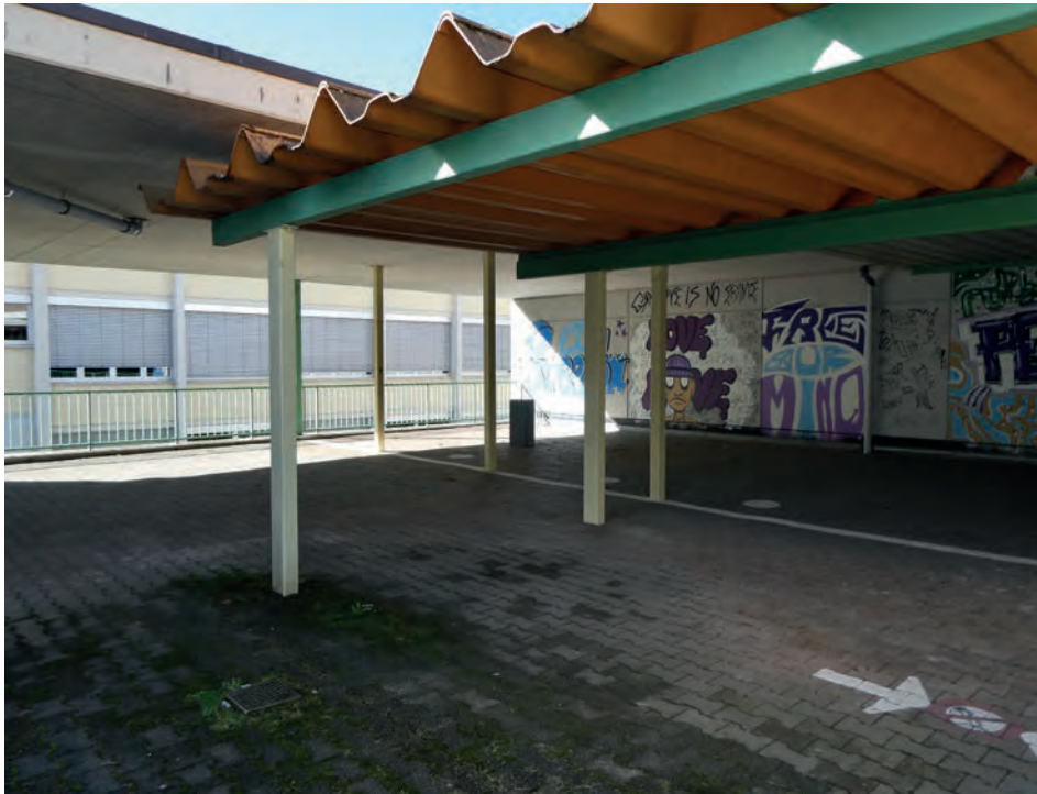
Foto 20: Außenanlage/Schulhof, südwestlicher Abschnitt Übersicht überdachter Bereich
