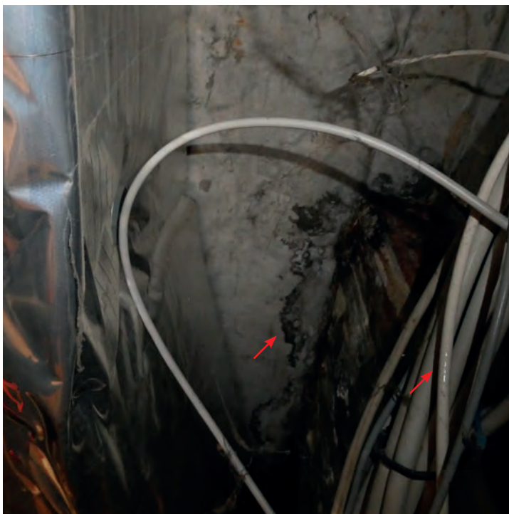
Foto 89: Innenbereich – Mittelflur Übersicht Flurabschnitt zu südlichem und mittlerem Hallendrittel – Deckenuntersicht Dunkle Verfärbungen und weißliche Ablagerungen auf Stahlbetonflächen Wasser auf Elektroleitungen
