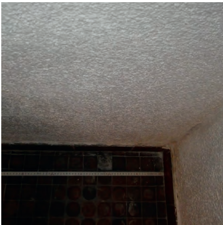
Foto 81: Umkleidekabine Nord Übersicht Nordöstliche Rauminnenecke, unterer Wandabschnitt Foto links: dunkel verfärbte Fugen in Bodenbelag Foto rechts: dunkel – rotbräunliche Verfärbungen im unteren Wandabschnitt und entlang Rauminnenecke
