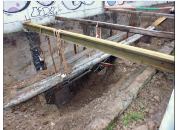
Abb. 7 Nordwestfassade – Aufhängung Erdleitungen
