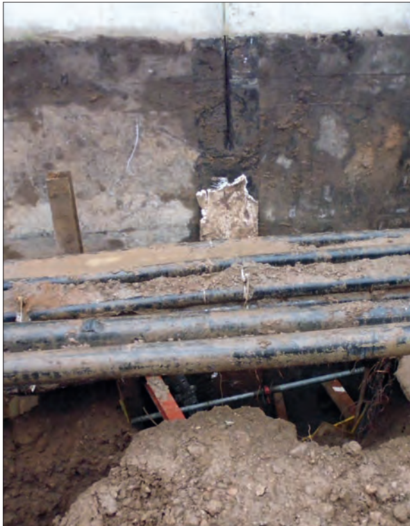
Abb. 17 Nordwestfassade Fuge vor nachträglicher Bauwerksabdichtung
