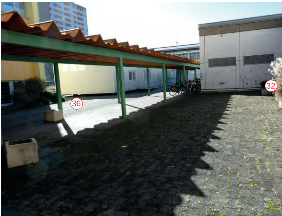
Foto 25: Außenanlage/Schulhof – westlicher Abschnitt Übersicht Überdachter Gebäudeverbindungsbau und Nordostfassade Haustechnikraum/Klimazentrale
