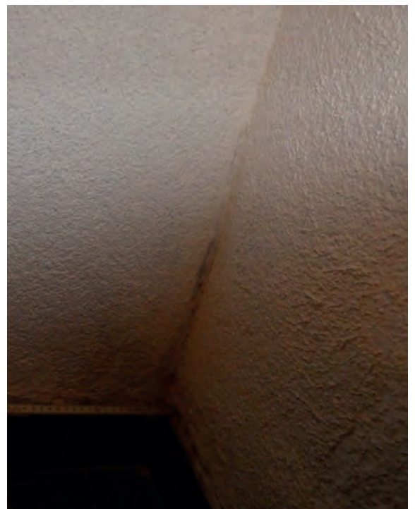
Foto 81: Umkleidekabine Nord Übersicht Nordöstliche Rauminnenecke, unterer Wandabschnitt Foto links: dunkel verfärbte Fugen in Bodenbelag Foto rechts: dunkel – rotbräunliche Verfärbungen im unteren Wandabschnitt und entlang Rauminnenecke
