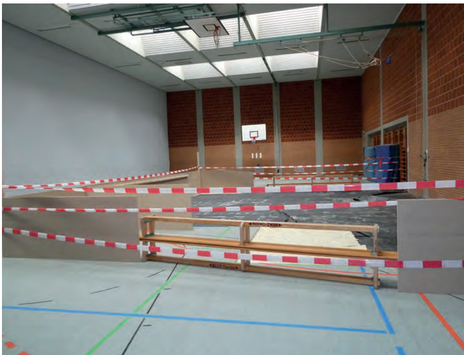
Foto 101: Sporthalle – nördliches Hallendrittel Übersicht aufgenommene Hallenbodenteilfläche hinter Absperrung
