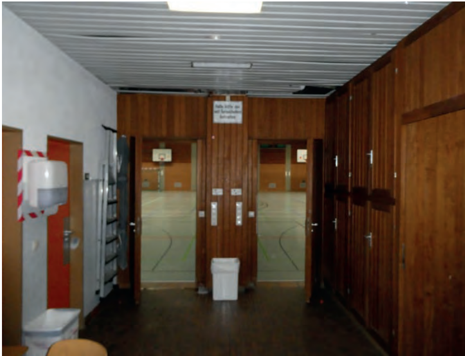
Foto 86: Innenbereich – Mittelflur Übersicht Flurabschnitt mit Zugängen zu südlichem und mittlerem Hallendrittel
