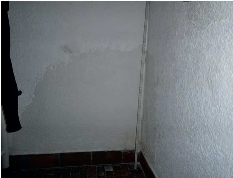
Foto 80: Umkleidekabine Nord Übersicht Nordöstliche Rauminnenecke, unterer Wandabschnitt
