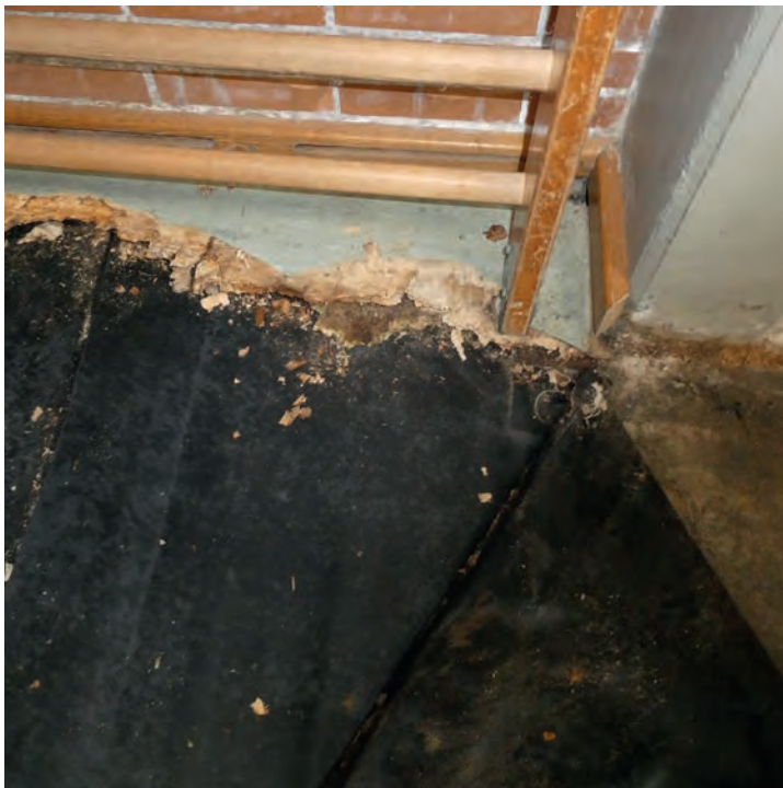
Foto 105: Sporthalle – nördliches Hallendrittel Detailaufnahmen Bodenanschlussbereich an nordöstliche Hallenwandfläche Foto links: Bodenabschnitt unterhalb Sprossenwand Foto rechts: Bodenaufbau an Giebelwandfuß bis auf Abdichtungsbahn aufgenommen
