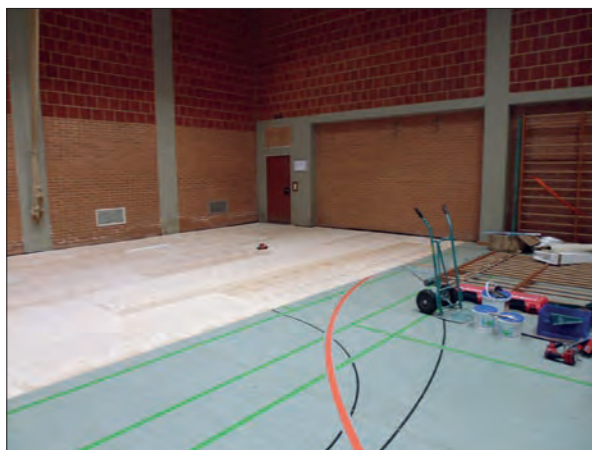
Abb. 34 Sporthalle, Nordwestecke – ohne Oberbelag
