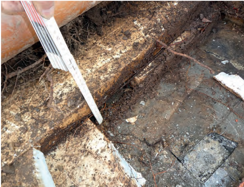
Foto 34: Sondageöffnung 02 Detailaufnahme zwei Dämmstofflagen à 50 mm auf bituminöser Abdichtungsbahn
