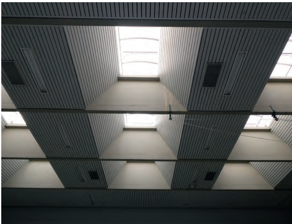
Foto 98: Sporthalle – mittleres Hallendrittel Übersicht Untersicht Decke und Lichtbänder
