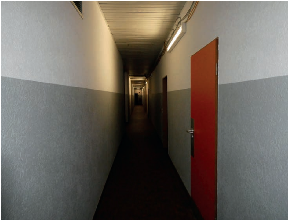
Foto 82: Innenbereich – Mittelflur Übersicht
