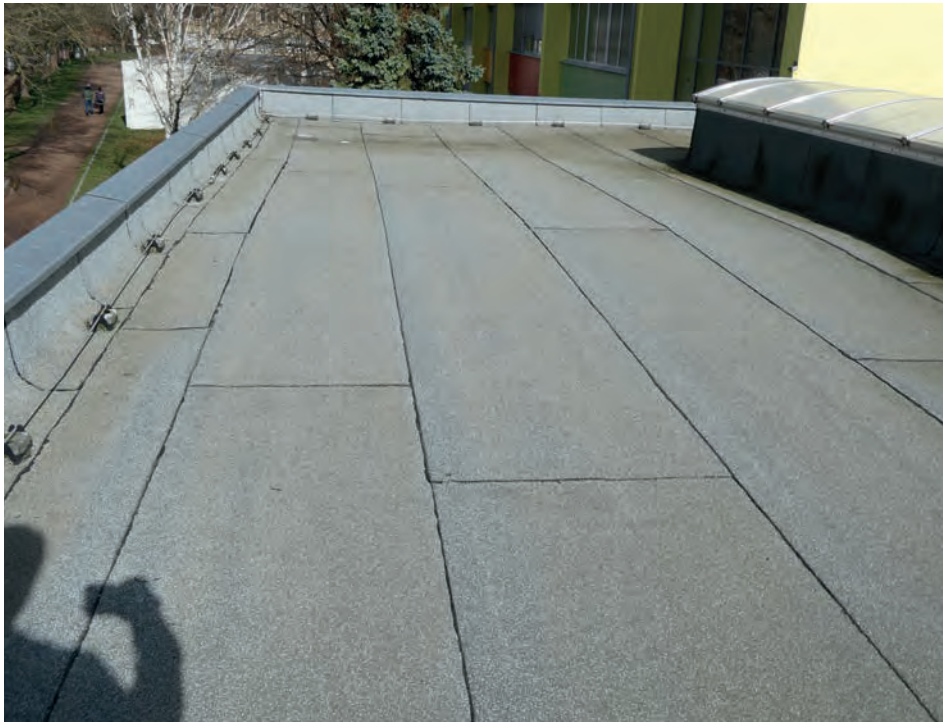
Foto 67: Sporthalle – Flachdach Übersicht Nördlicher Flachdacheckbereich
