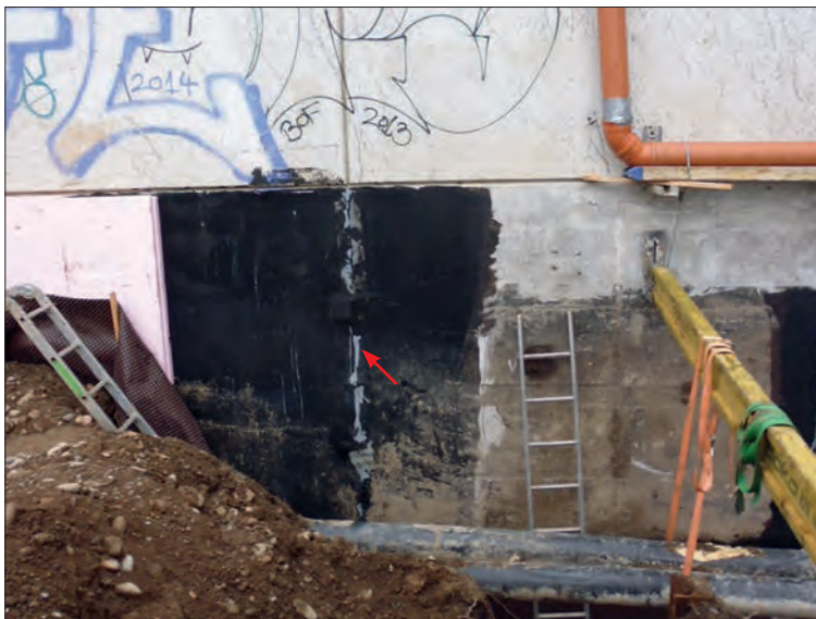
Abb. 22 Nordwestfassade – Dichtband in Abdichtung eingebettet
