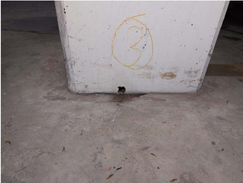
Foto A3: Untersuchungsstelle 3 – Stützensockel obere Parkebene
