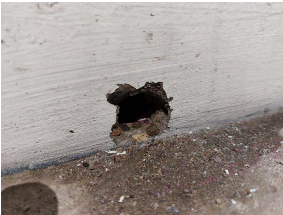
Foto A4: Untersuchungsstelle 3 – Karbonatisierungstiefe ca. 15 mm
