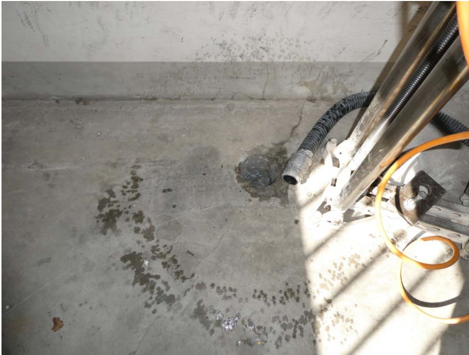
Foto 23: Obere Parkebene – Bohrkernentnahme Zwischendecke im Bereich Trennriss
