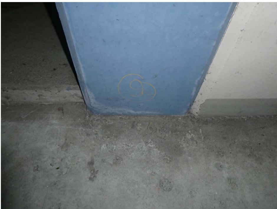
Foto 46: Untersuchungsstelle 9 – Stützensockel ungeschädigt
