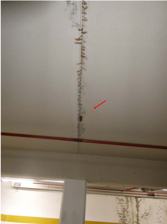
Foto 59: Untersuchungsstelle 17 – Decke untere Parkebene
