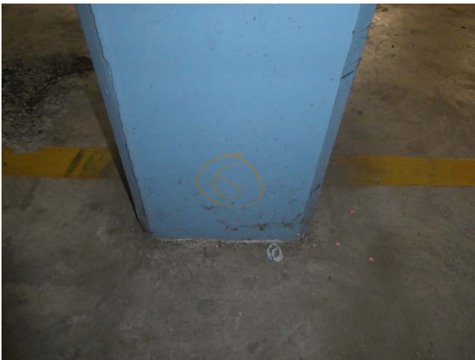
Foto 40: Untersuchungsstelle 6 – Stützensockel ungeschädigt
