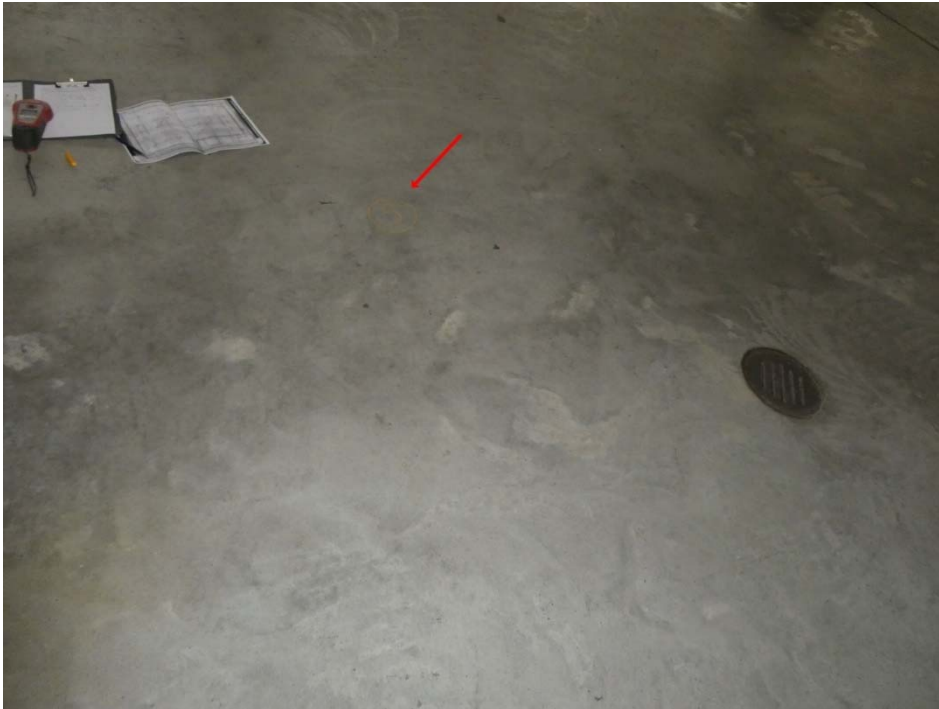
Foto 37: Untersuchungsstelle 5 – Bodenfläche obere Parkebene neben Bodeneinlauf
