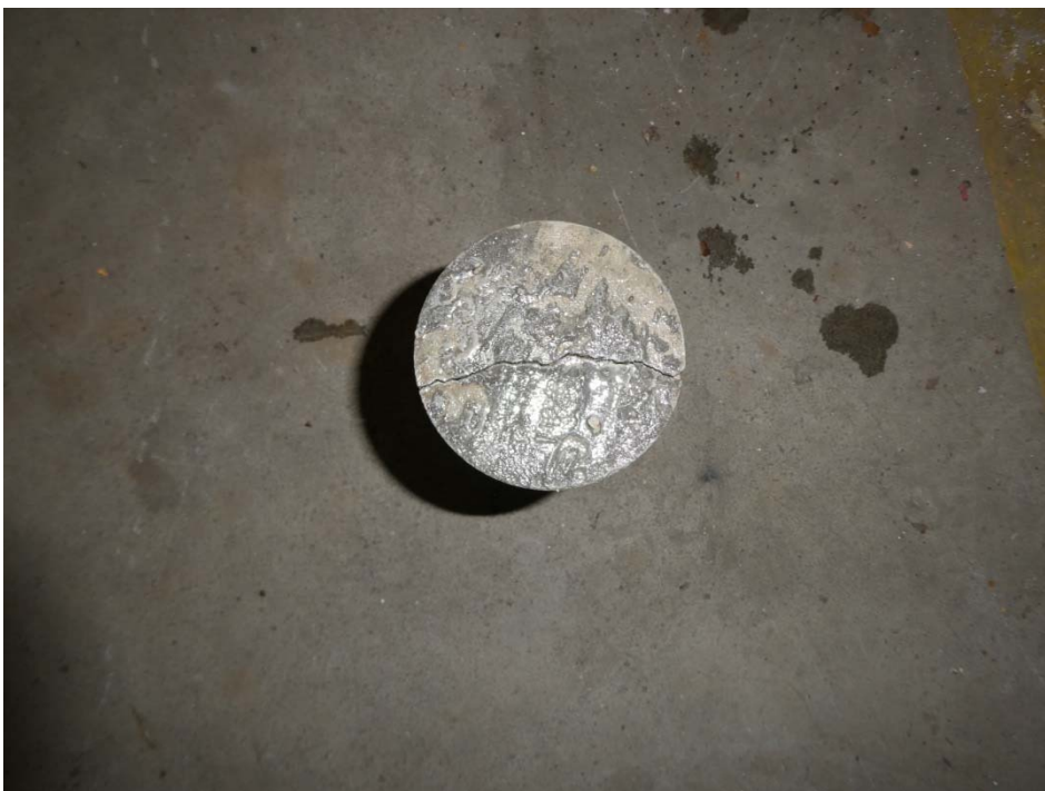
Foto 28: Obere Parkebene – Bohrkernentnahme Zwischendecke im Bereich Trennriss
