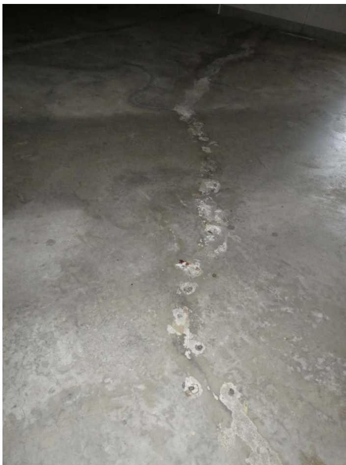
Foto 6: Obere Parkebene – Bodenrisse, teilweise verpresst
