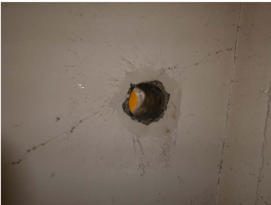
Foto 24: Untere Parkebene – Bohrkernentnahme Zwischendecke im Bereich Trennriss
