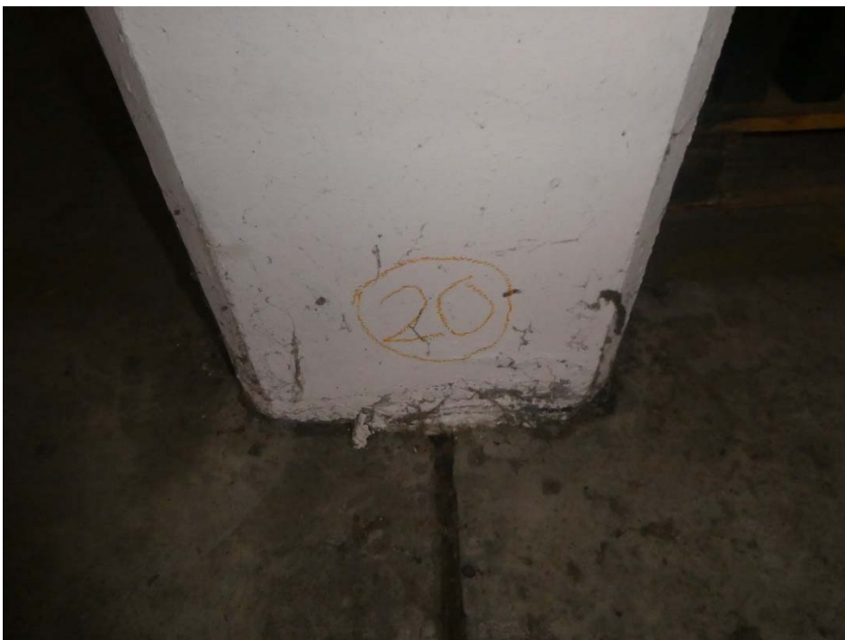
Foto 66: Untersuchungsstelle 20 – Stützensockel ungeschädigt
