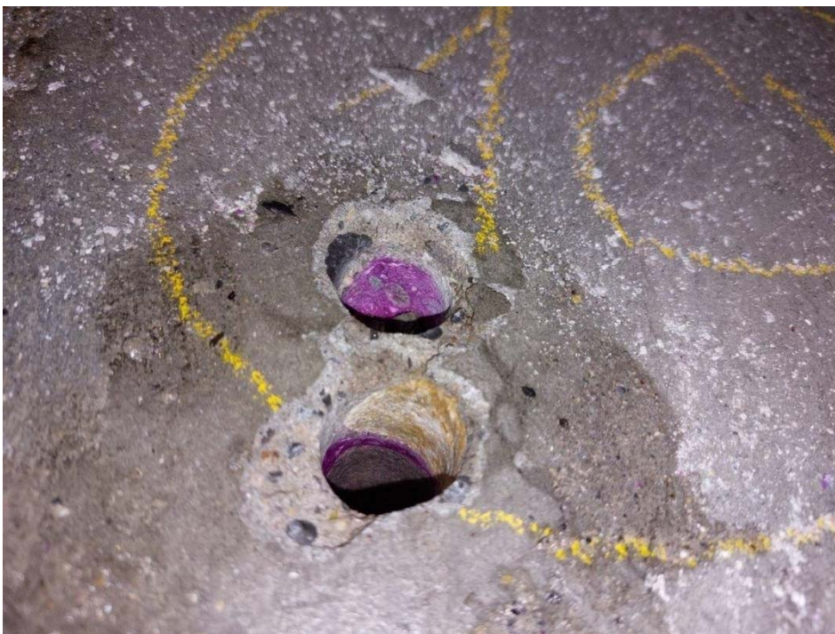
Foto A12: Untersuchungsstelle 10 – Karbonatisierungstiefe ca. 18 mm
