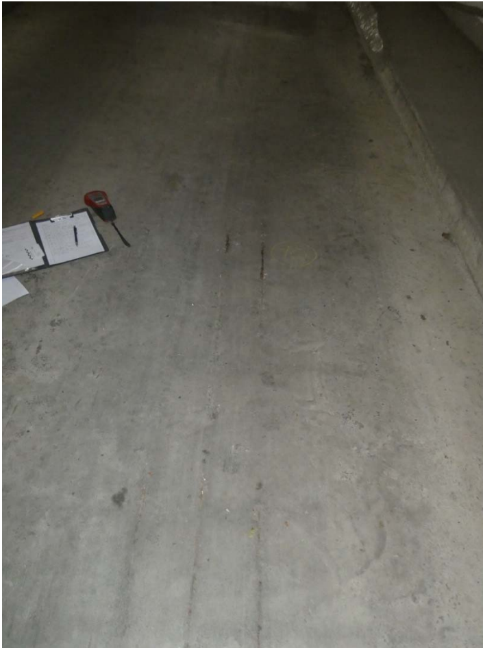
Foto 47: Untersuchungsstelle 10 – Bodenfläche Abfahrtsrampe zur unteren Parkebene
