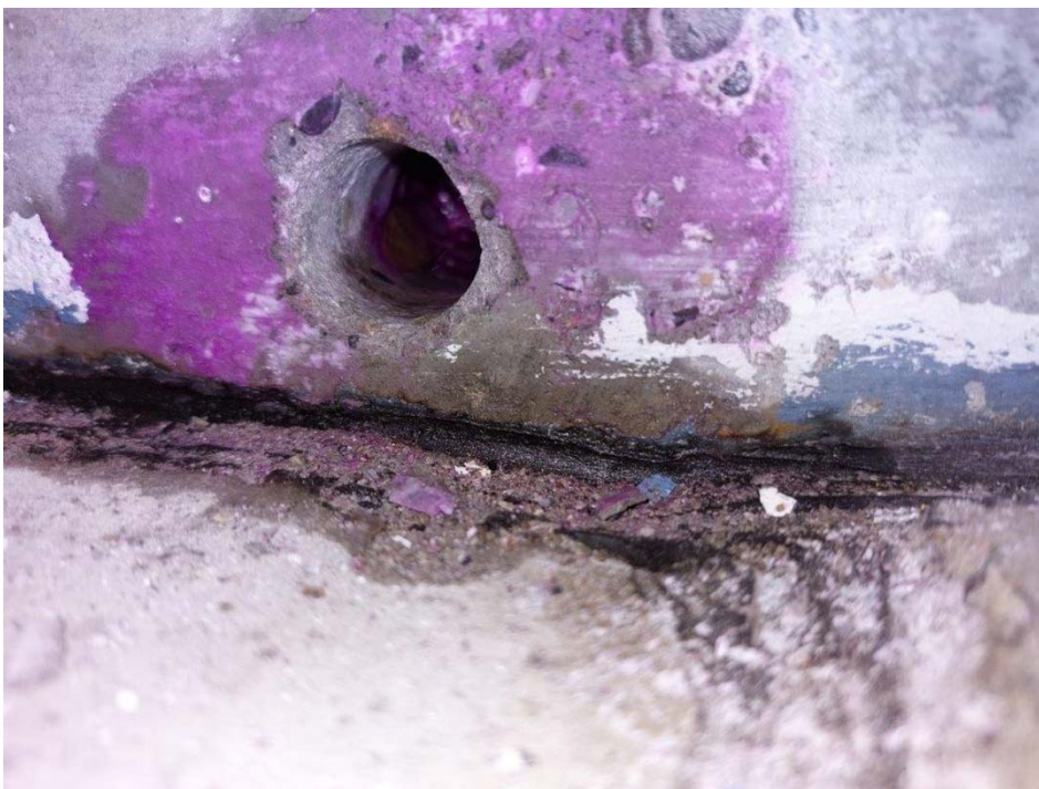
Foto A18: Untersuchungsstelle 20 – Karbonatisierungstiefe ca. 20 mm
