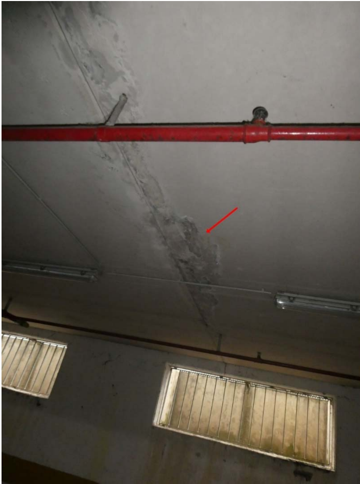
Foto 61: Untersuchungsstelle 18 – Decke untere Parkebene
