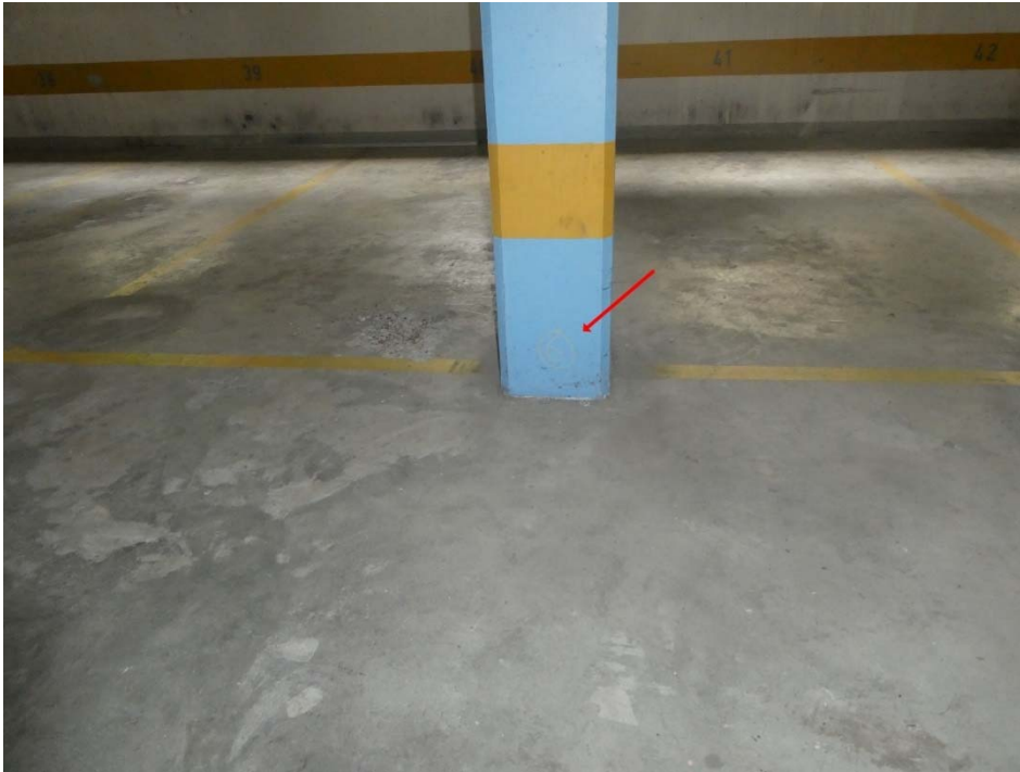
Foto 39: Untersuchungsstelle 6 – Stützensockel obere Parkebene
