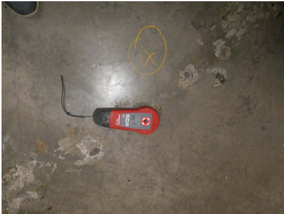
Foto 35: Untersuchungsstelle 4 – Ermittlung der Betonüberdeckung
