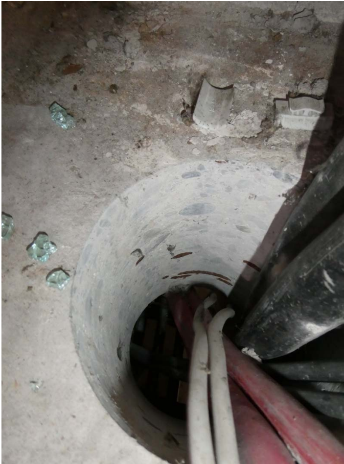
Foto 19: Obere Parkebene – Installationsbohrung durch Zwischendecke
