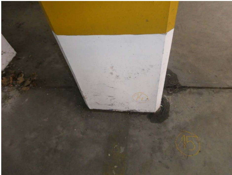
Foto 55: Untersuchungsstelle 14 – Stützensockel neben Dehnfuge unteren Parkebene
