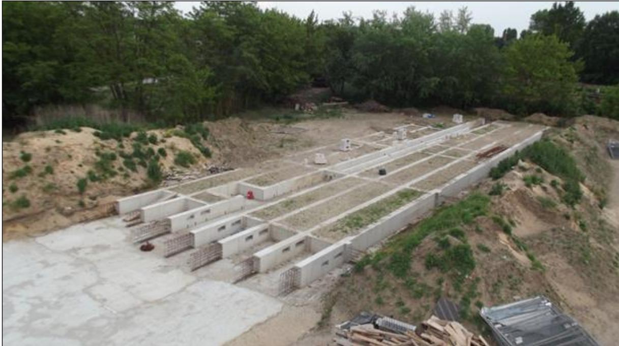
Abbildung 11: Gründung eines Containergebäudes (Beispiel)<sup>3</sup>
