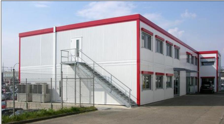
Abbildung 9: Beispiel für ein Gebäude in Containerbauweise mit Flachdach<sup>2</sup>
