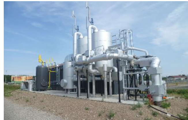
Aufbereitungsanlage Biomethan
